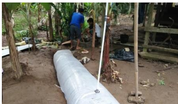
Gambar 3. Hasil Uji Coba Instalasi Biogas
