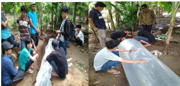
Gambar 2. Pemasangan Instalasi Biogas
