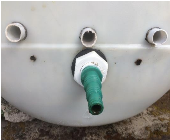
Gambar 1. Modifikasi outlet pada unit komposter
