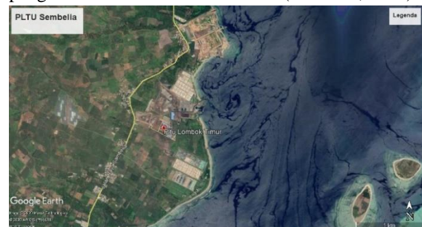
Gambar 1. Lokasi PLTU Sembelia, Jalan Raya Sembelia, Padak Guar, Lombok Timur, Nusa Tenggara Barat Sambelia
